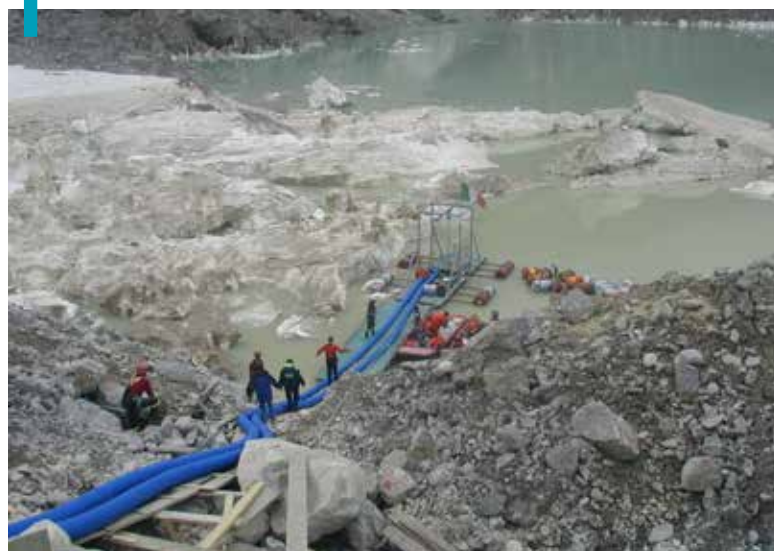
Sistema di pompaggio messo in opera nell'estate 2002 per abbassare il livello del Lago Effimero formatosi sulla superficie del Ghiacciaio del Belvedere, alla base della parete Est del Monte Rosa
