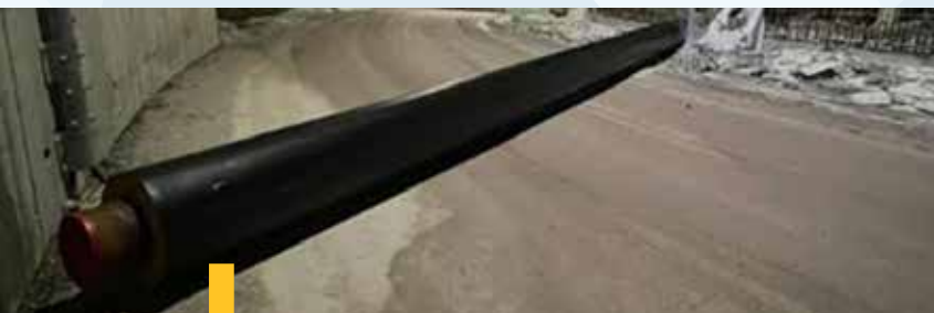
IL TUBO NEL CANTIERE DELLA PISTA DA BOB DI CORTINA @ ILFATTOQUOTIDIANO
