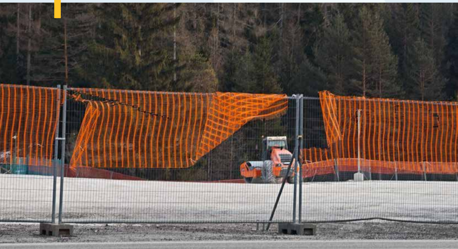
CANTIERE PARCHEGGIO TEMPORANEO FIAMES © FABIO TULLIO
