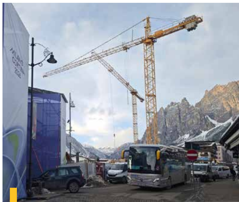
LAVORI IN CORSO E TRAFFICO CORTINA D'AMPEZZO - FEBBRAIO 2026 © FABIO TULLIO
