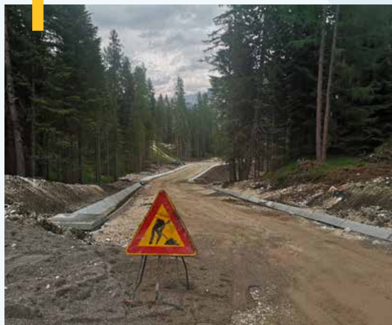
LAVORI NEL BOSCO, CORTINA D'AMPEZZO, 2021 © FABIO TULLIO
