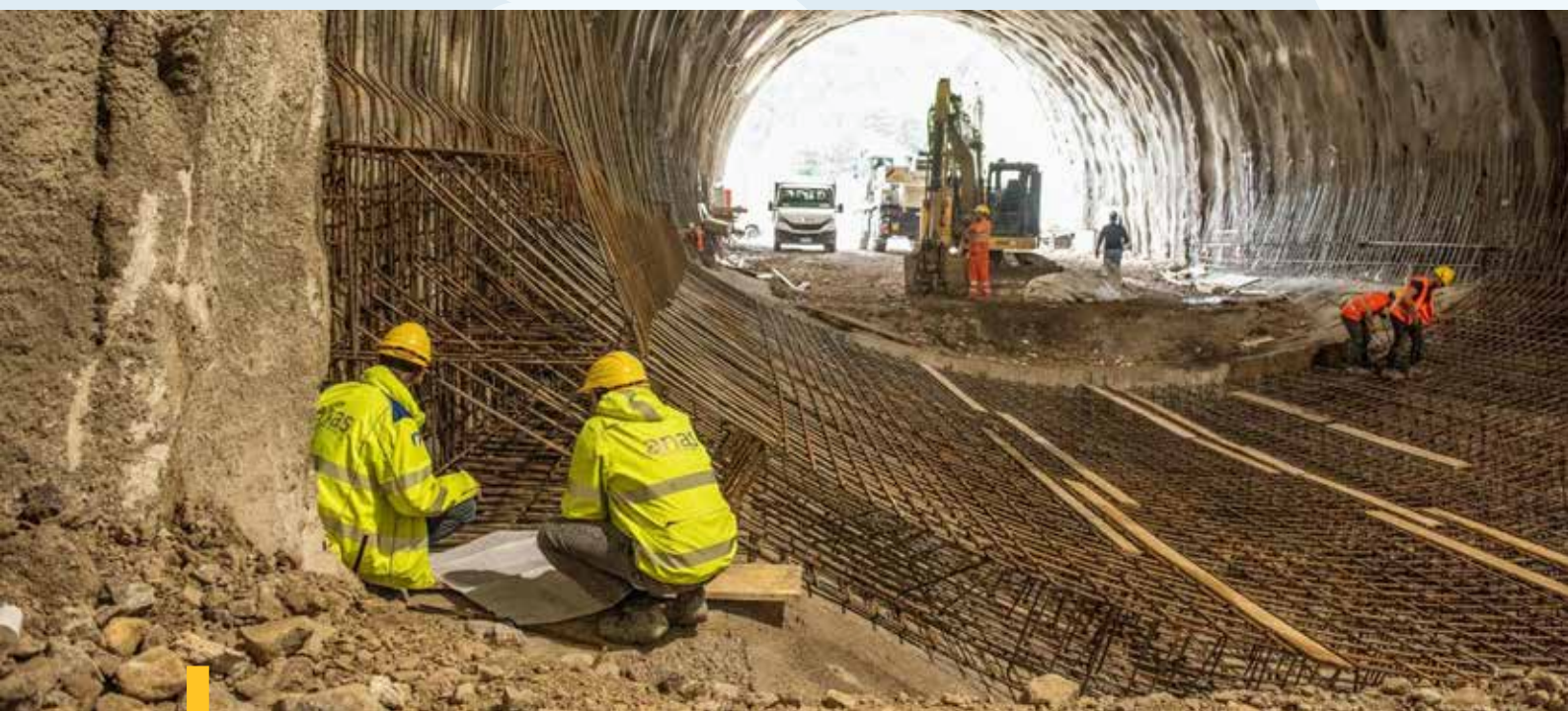
LAVORI IN GALLERIA, VARIANTE VALLE DI CADORE © ANAS
