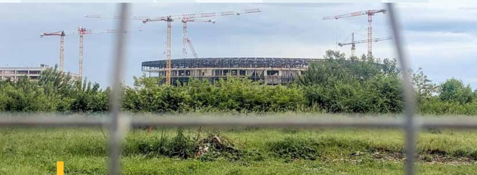
CANTIERE ARENA SANTA GIULIA
