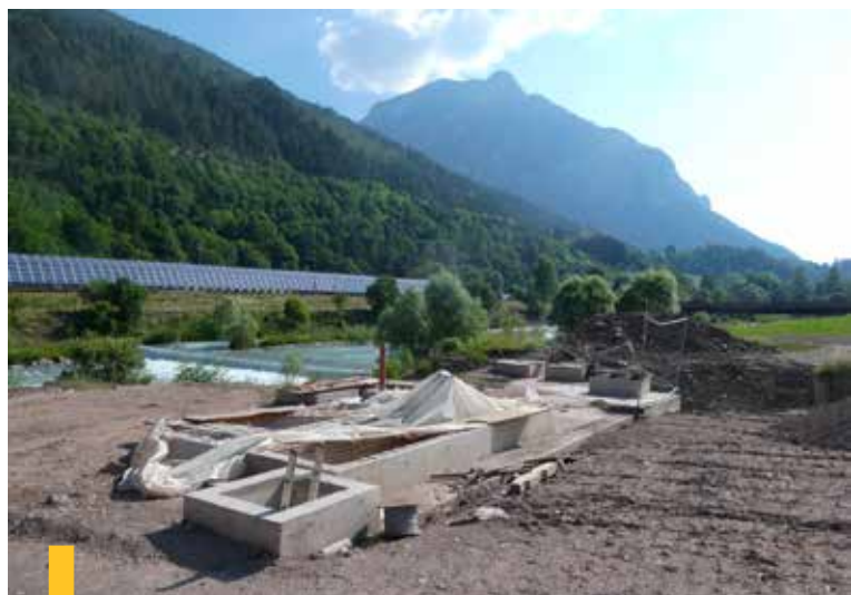
CANTIERE NUOVA PRESA, TORRENTE AVISIO, TESERO (TRENTO) © LUIGI CASANOVA
