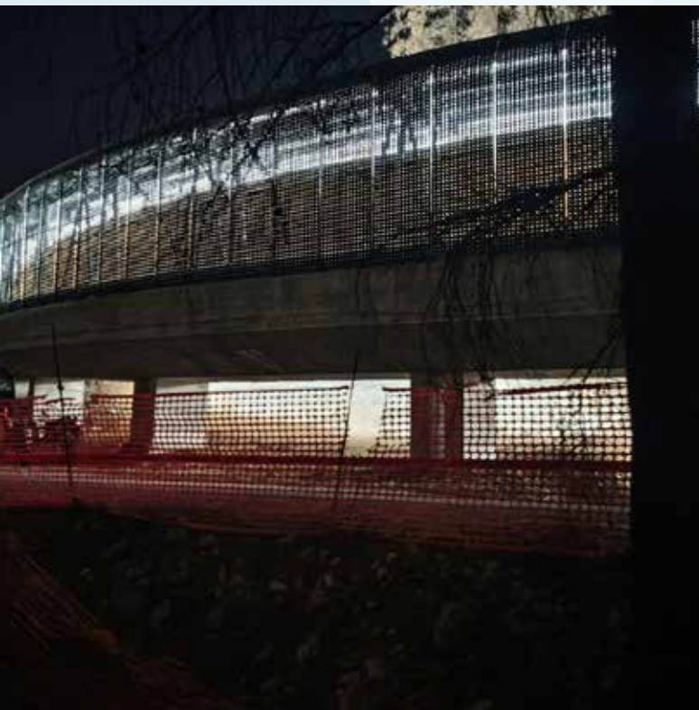
CANTIERE SLIDING CENTRE CORTINA D'AMPEZZO © FABIO TULLIO
