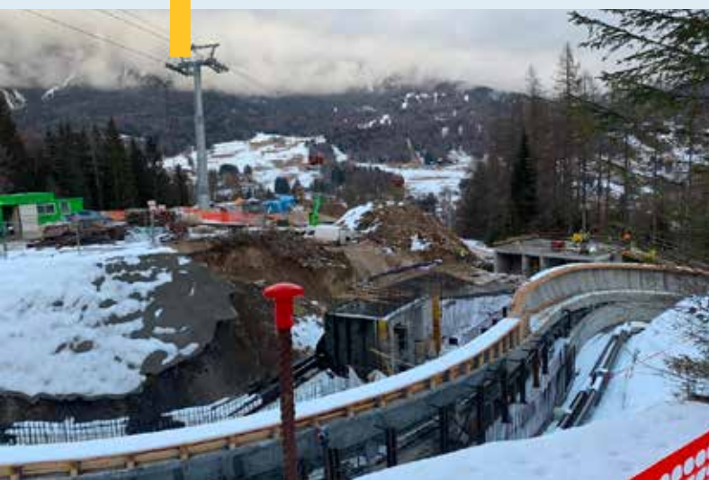
LAVORI IN CORSO SLIDING CENTRE, GENNAIO 2025, CORTINA D'AMPEZZO © FABIO TULLIO
