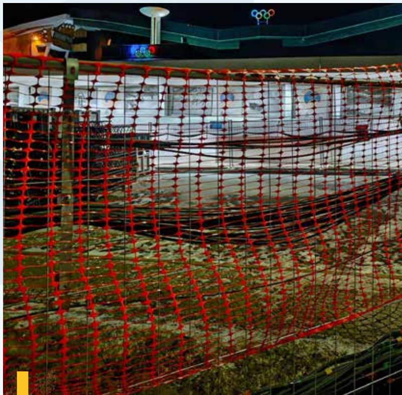
CANTIERE RIQUALIFICAZIONE STADIO DEL GHIACCIO DI CORTINA D'AMPEZZO © FABIO TULLIO
